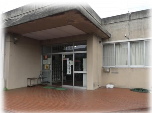
今年度で解体となる共和公民館
