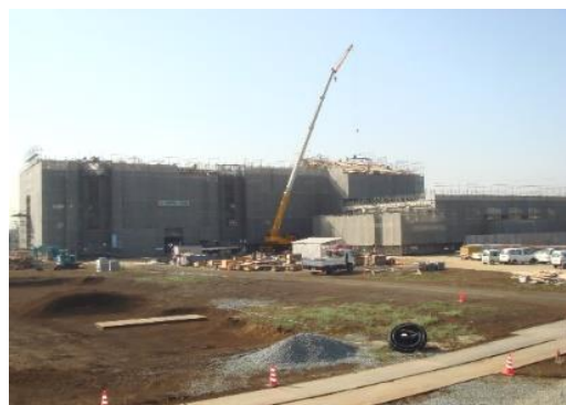
校舎建設の様子
